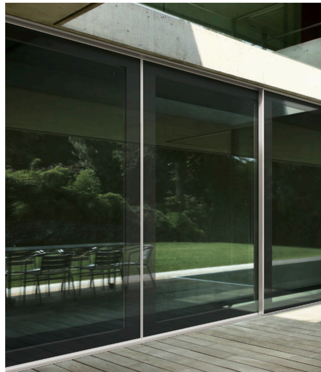
Sopra: vista esterna scorrevole alzante a 4 ante con telaio in alluminio anodizzato e vetro riflettente grigio. A sinistra: vista interna con fodera di rivestimento in rovere grigio.
