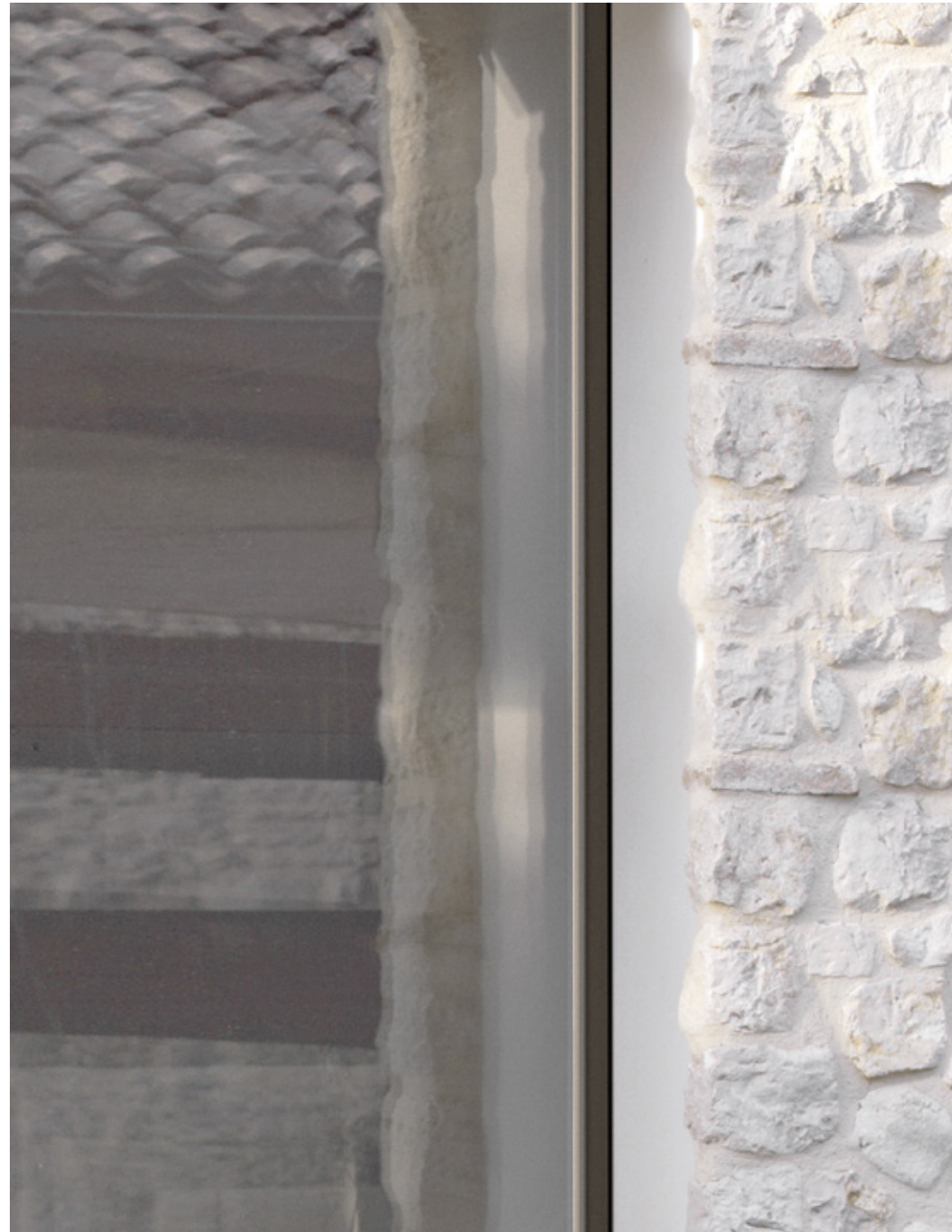
Sopra: dettaglio installazione in luce coplanare. A destra: porta finestra due ante in luce coplanare finitura alluminio brown, vetro riflettente chiaro.
